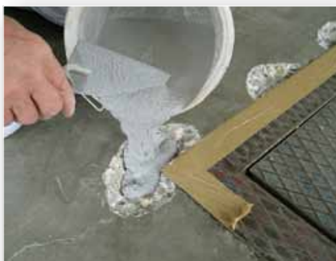
... verfüllen und abziehen.
